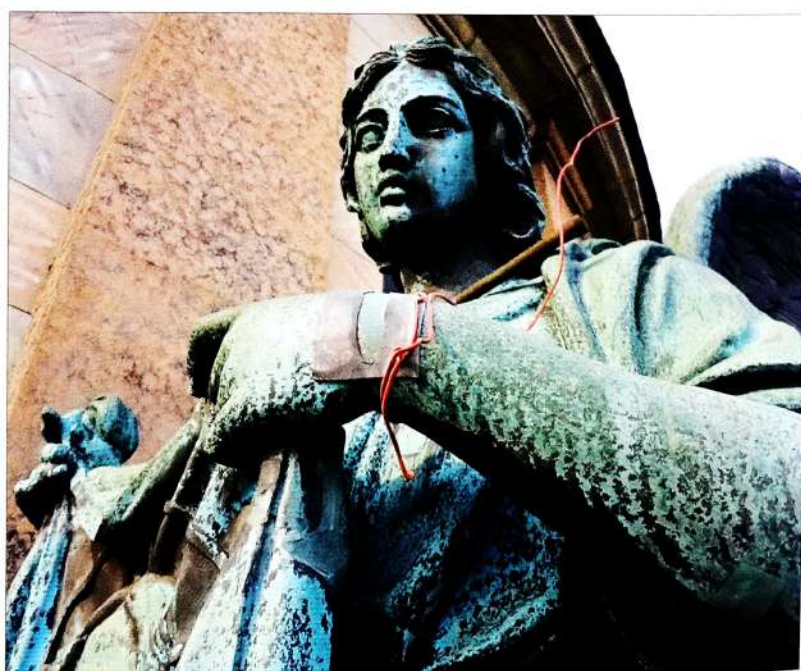
Место напыления патины, определенное конфигурацией шаблона на левой руке скульптуры «Ангел с нерукотворным образом». Фотография П.Г. Щедрина. 2013
