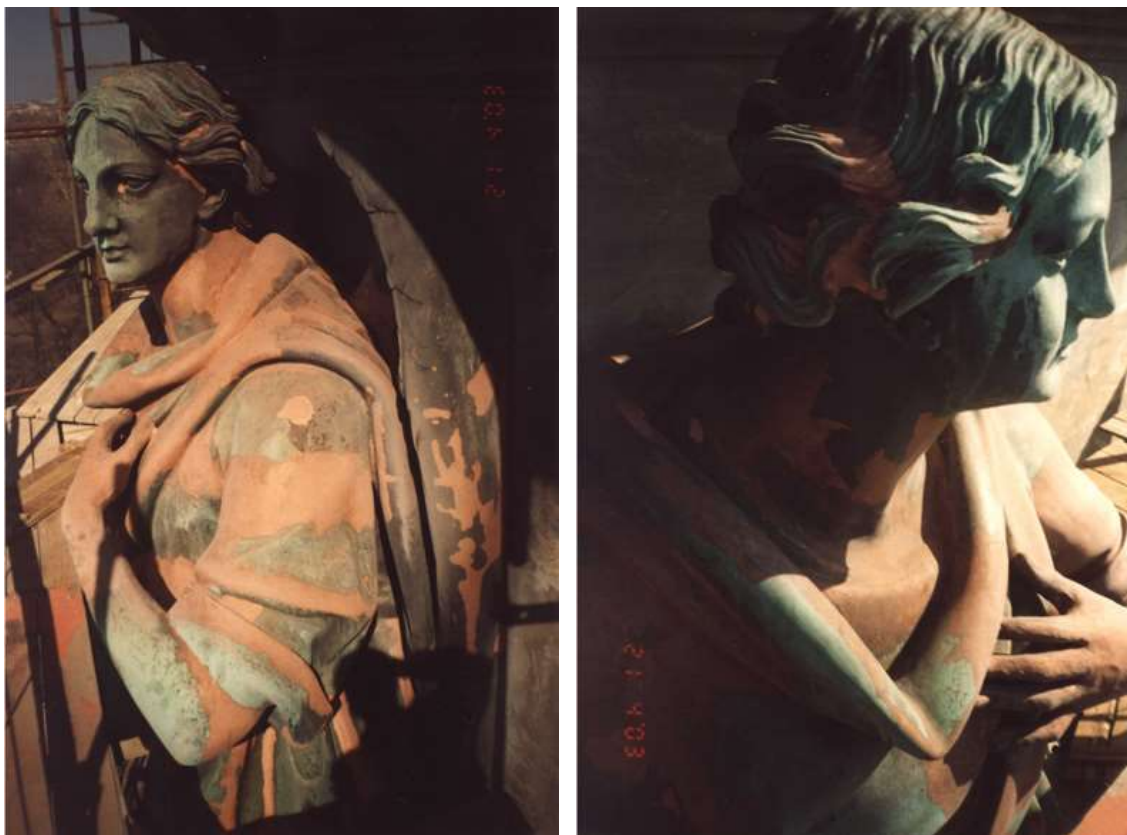
Рисунок 3 — Реставрация Ангела Исаакиевского Собора методом ХГДН
