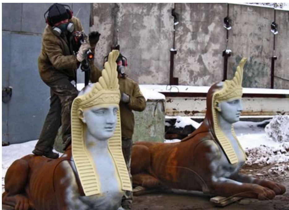
Рисунок 4 — Напыление латунного покрытия на декоративные украшения головных уборов сфинксов и цинкового покрытия на их тела
