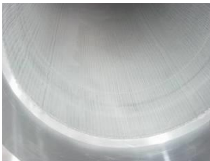
Рисунок 6.12. Внешний вид защитного покрытия на внутренней стороне секции
